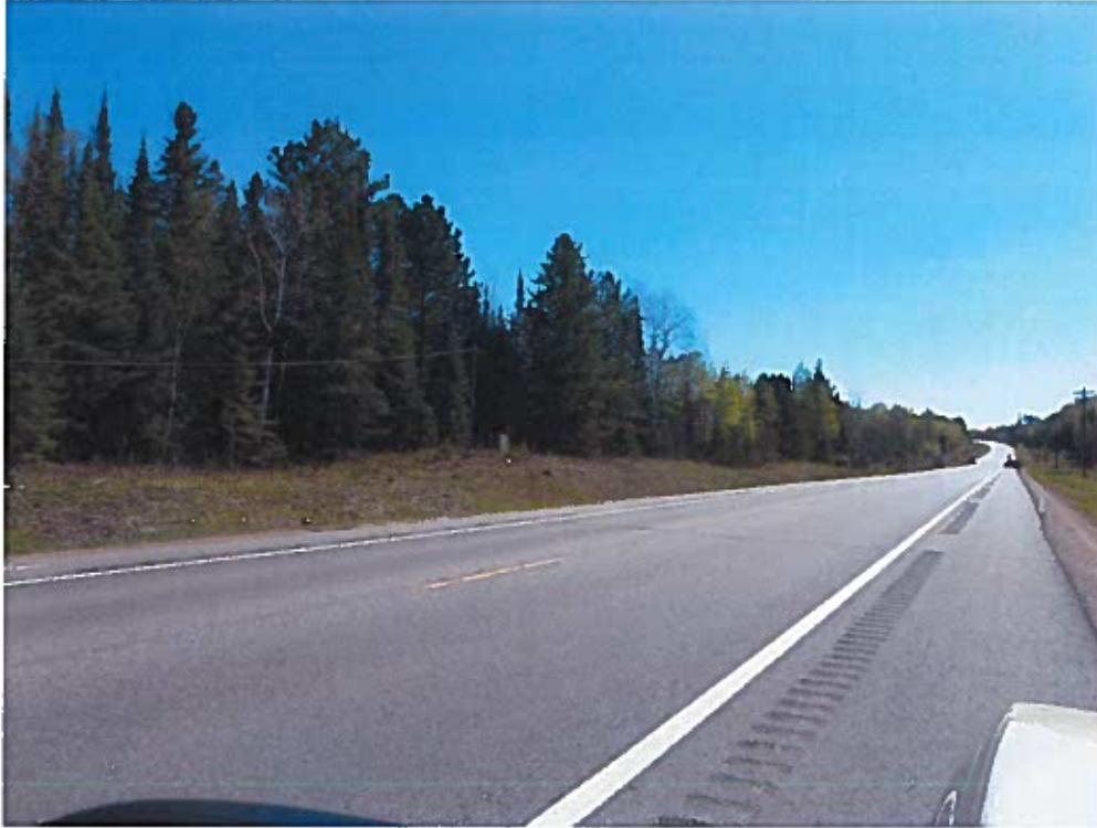
CSAH 110/Bridge 488 Looking East
